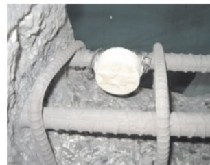
Anodo de sacrifício para vigas e pilares
