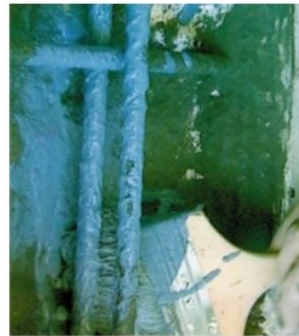
foto de tratamento tradicional em barras de aço corroidas
