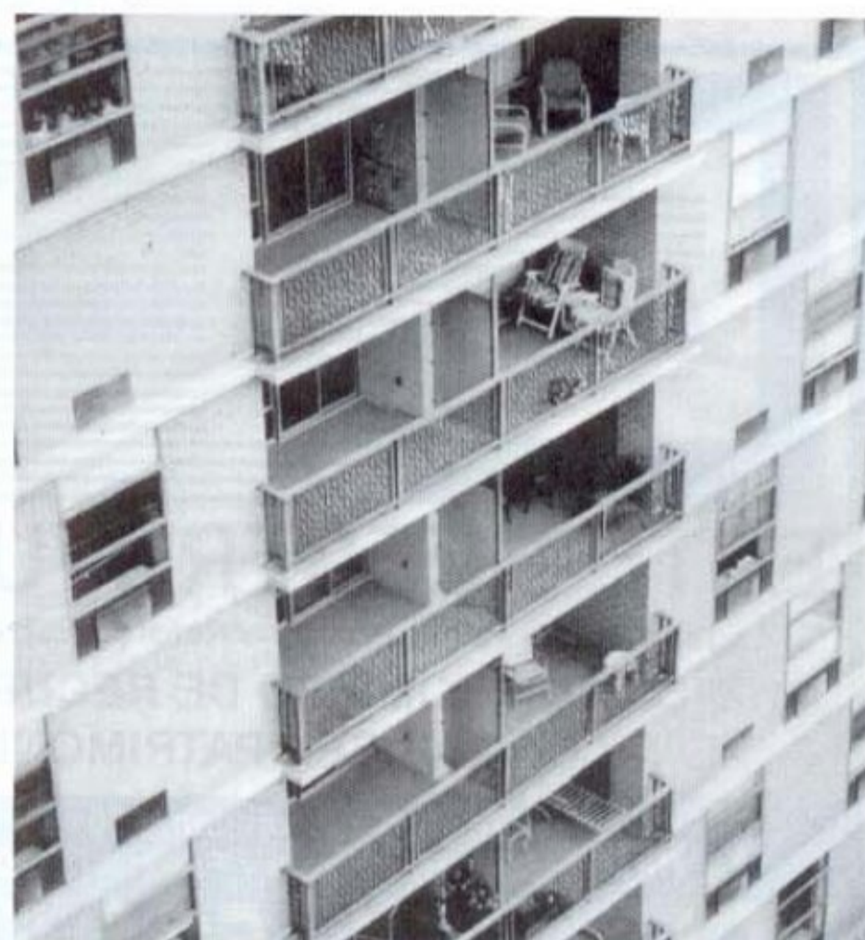
Varandas já recuperadas e reforçadas. Utilizou-se pintura elastomérica para a proteção das superfícies.
