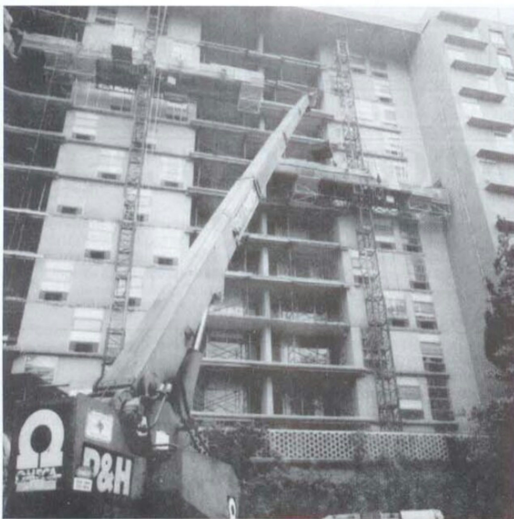
Um guindaste fornece argamassa estrutural ao pessoal alocado nas plataformas.
